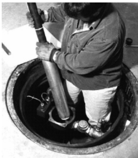
FIGURE 3.2 INSTALLATION D'UNE POMPE CPT
