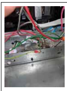
Figura 37: Conexión del alambre de tierra al riel del marco
