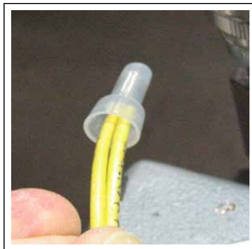
Figura 24: Prensado del cable - 2
