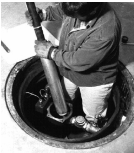
FIGURE 3.2 INSTALLATION D'UNE POMPE CPT
